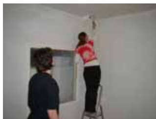
afwerking van de muren
